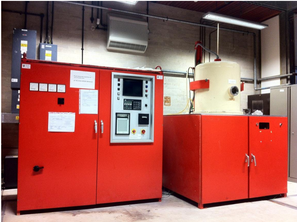
Figure.3.1.1 60kw Klöckner DC plasma unit
